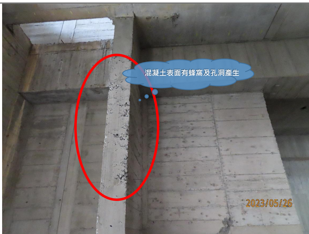
混凝土表面有蜂窩及孔洞
