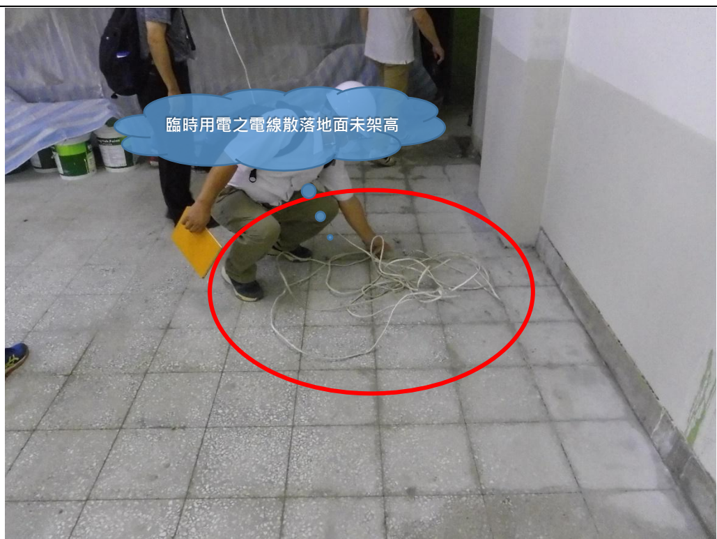
臨時用電之電線散落地面未架高
