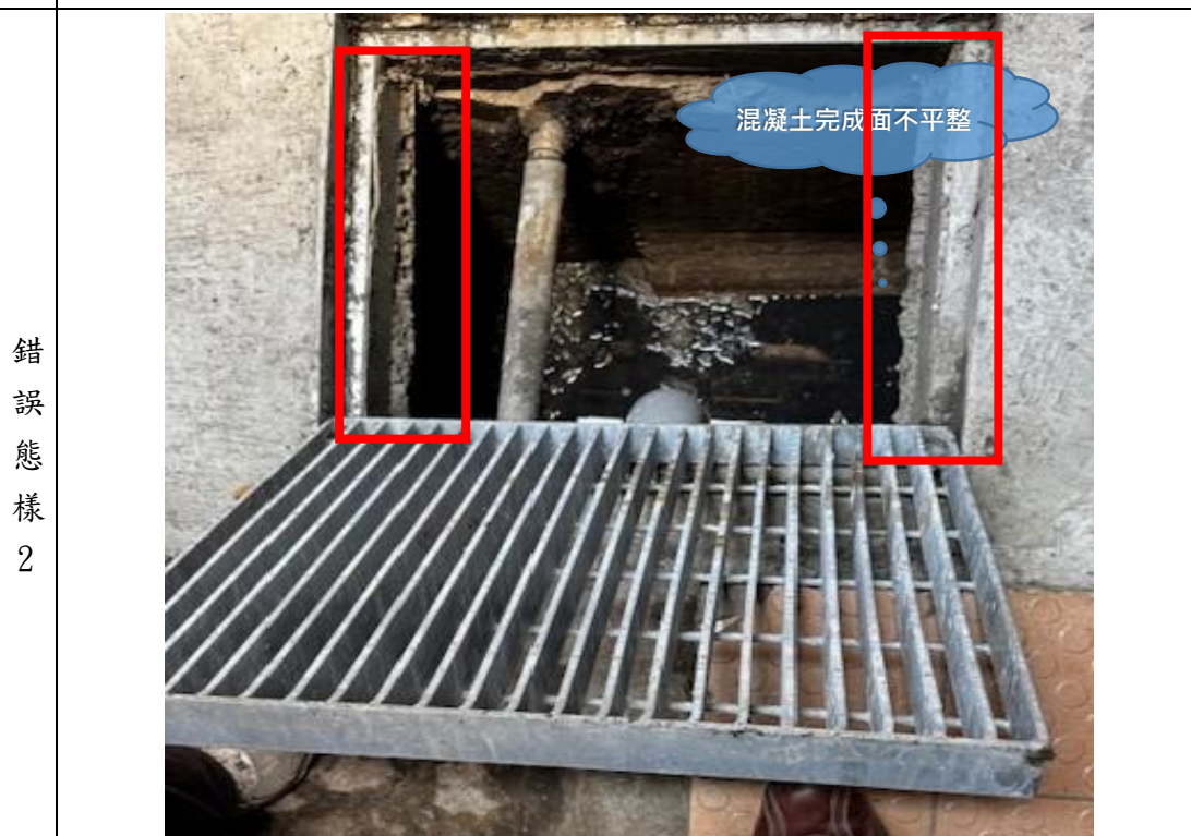
格柵蓋板內部周邊有混凝土表面不平整情形
