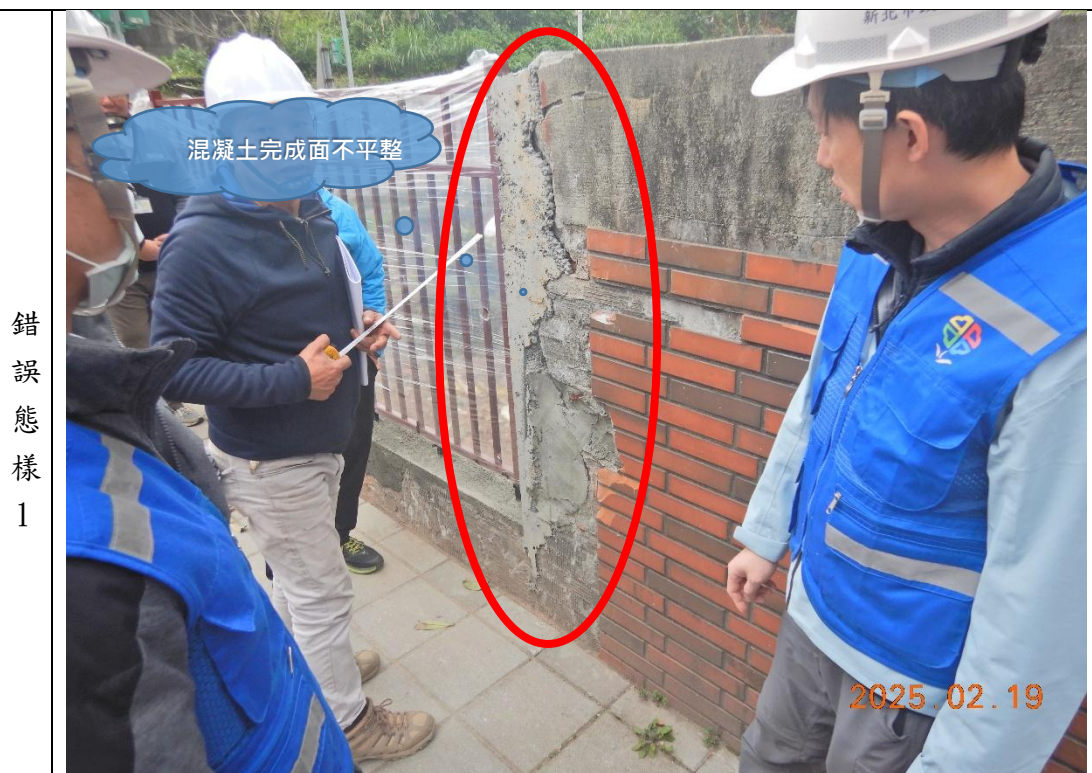
圍牆與其他構造物新舊交接面及混凝土圍牆不平整
