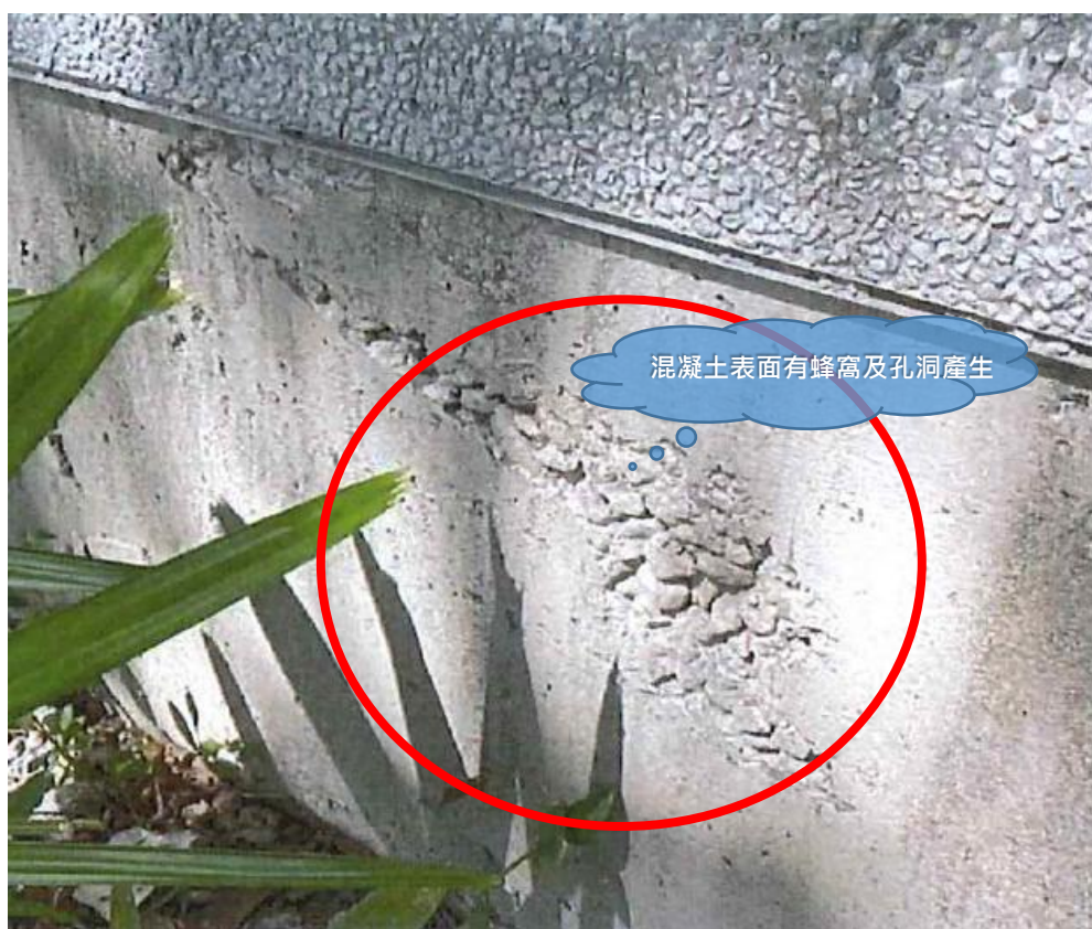
混凝土表面有蜂窩及孔洞
