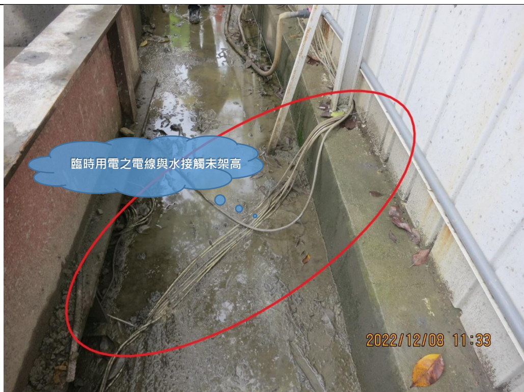
臨時用電之電線與水接觸未架高
