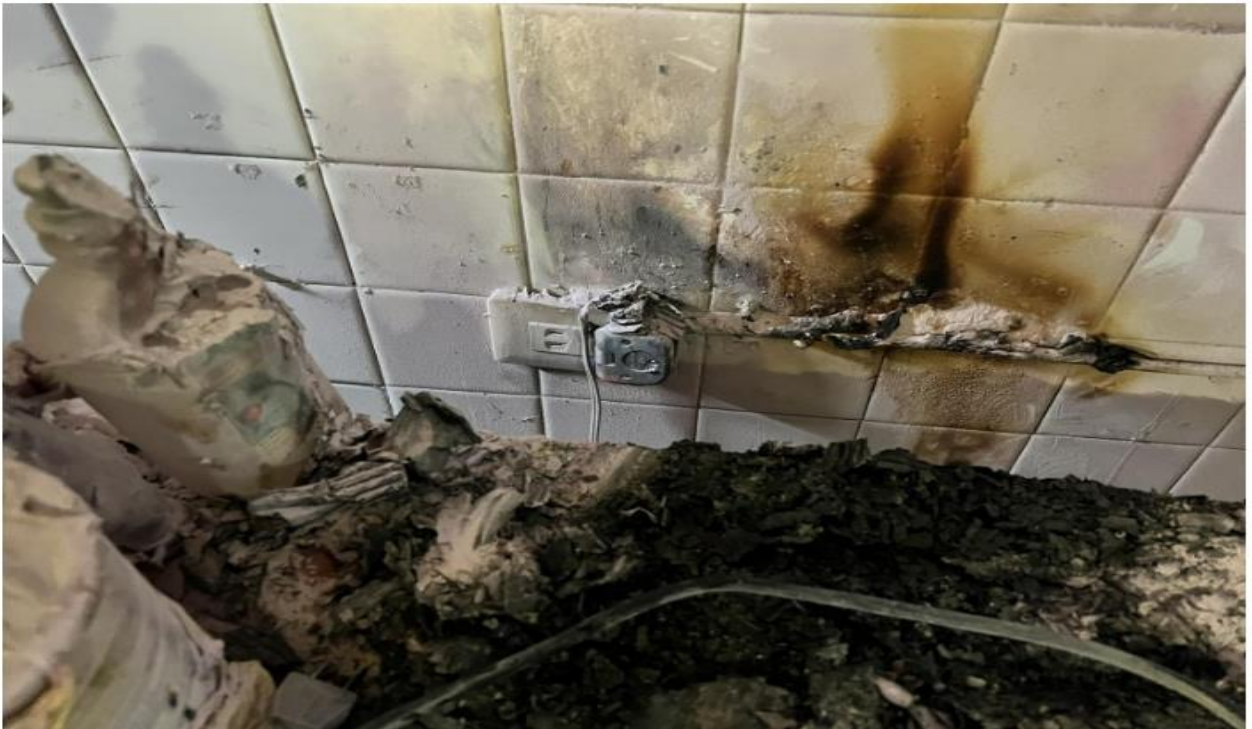
從插座內再拉電線出來，自行擴建電源插座，比用延長線更可怕。(圖／取自119急救現場臉書專頁)
