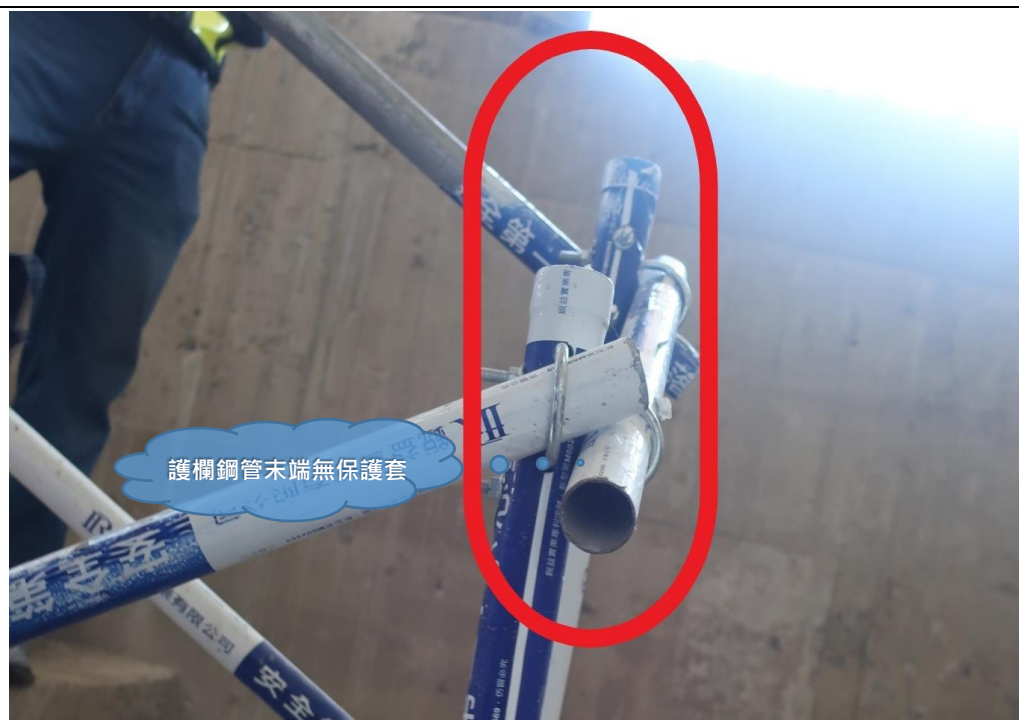
護欄鋼管末端無保護套
