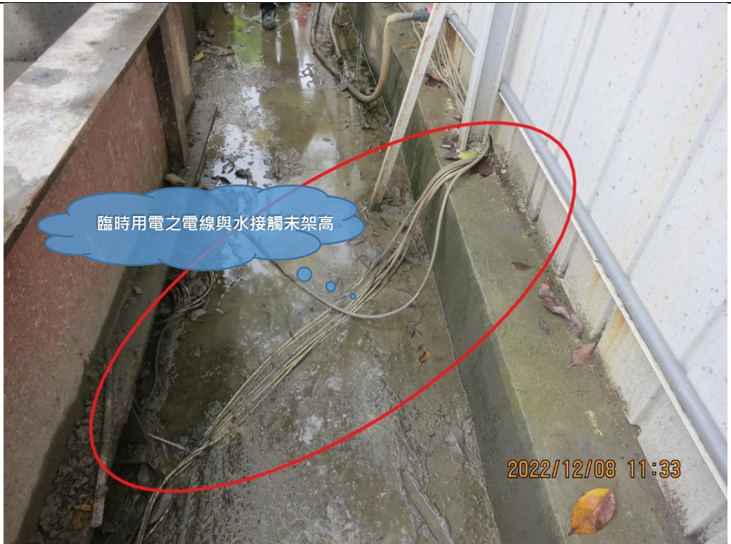
臨時用電之電線與水接觸未架高
